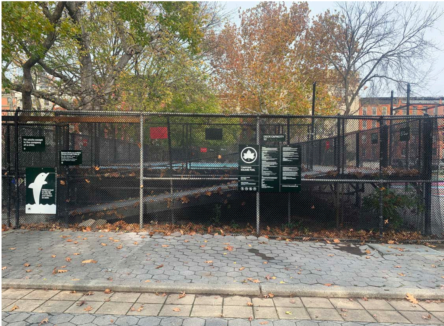
9 - Mini Pool Ramp & Fence
